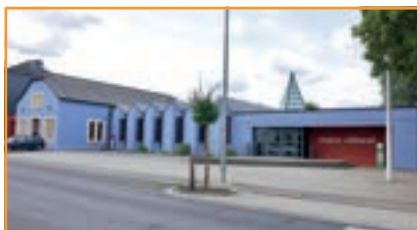
Kulturzentrum Helmdingen Centre culturel Helmdange
